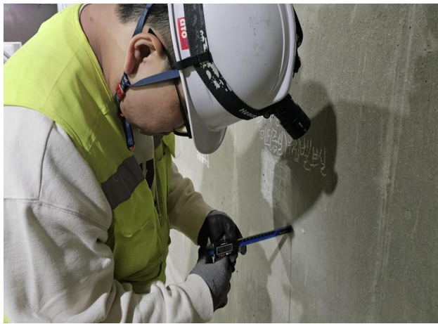
탄산화 깊이 측정
