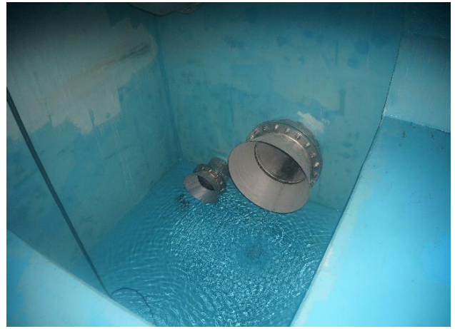
배수지 1지 유출관 및 퇴수관 상태양호
